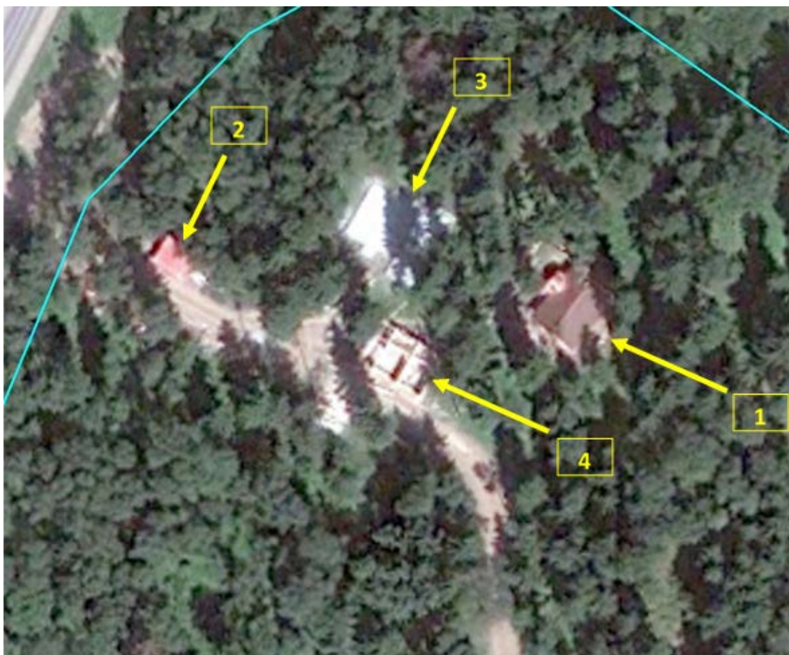
Рисунок 3. Снимок от 05.07.2014. Зона активного строительства.
